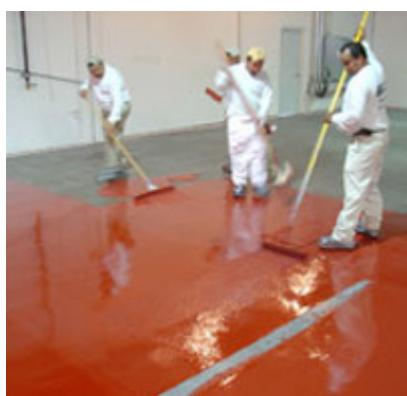
**Primjena:** Proizvod se nanosi ne razrjeđen na temeljno očišćen i suh pod. Prije nanošenja na podu ne smiju biti ostaci sredstva za temeljno čišćenje.
